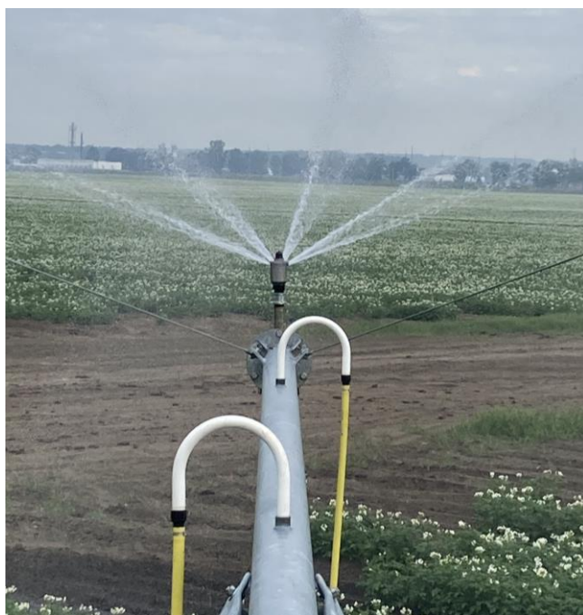
Рисунок 2 – Фрагмент основного трубопровода дождевальной машины с U – образными отводами дождевателей и концевым спринклером
